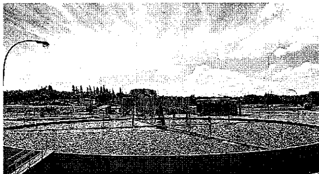
Planta. La Estación Depuradora de Aguas Residuales hace muchos años que trabaja con deficiencias. Los líquidos se arrojan al río Suquia casi con la misma carga de contaminación con la que ingresan. (IMAGEN DE LA Voz)
